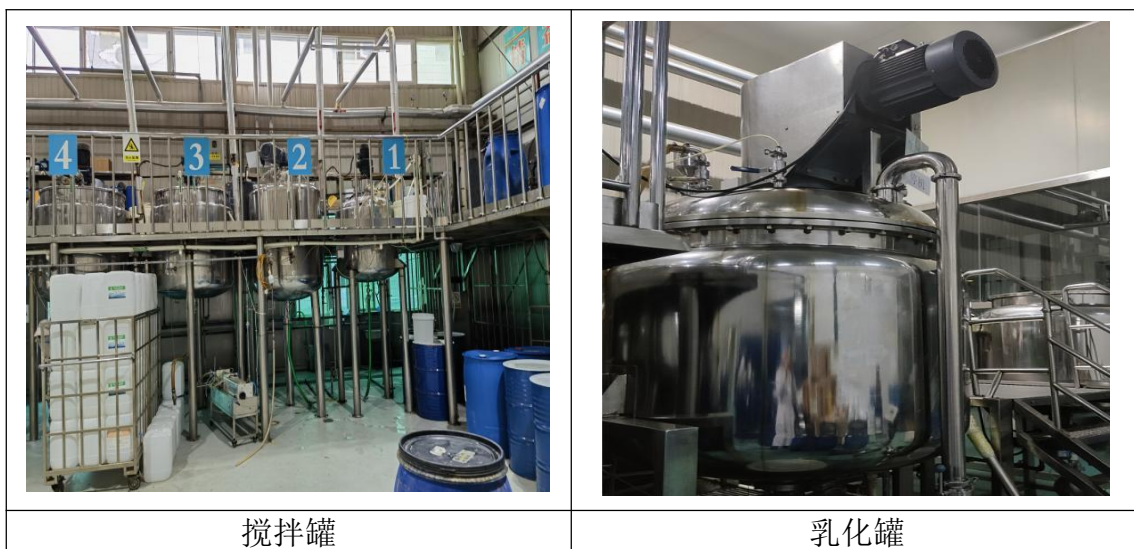
图 5.1-2 搅拌罐、乳化罐照片
